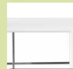
n°3 Croisillon plomb intégré dans le vitrage.
