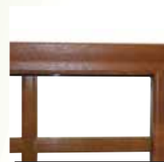
n°16 Ton bois, croisillon intégré dans le vitrage.
