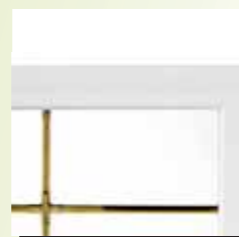
n°7 Croisillon laiton intégré dans le vitrage.
