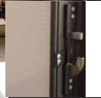
1 coffre de pêne + 1 butée et 1 ergot anti-soulèvement par panneau.
