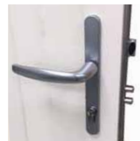
Point latéral : serrure + 2 pènes cylindriques.
